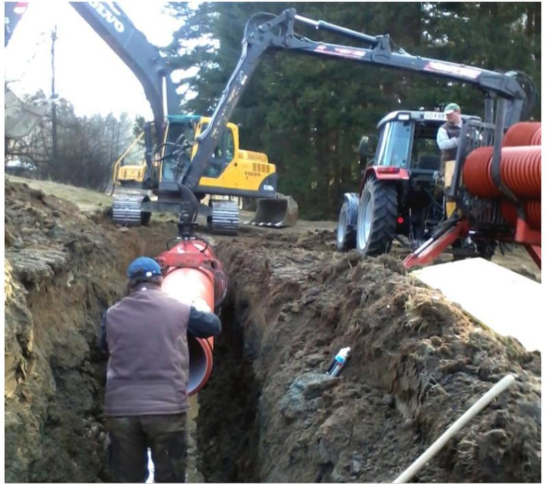
Errichtung eines Regenwasserumleiters in Engelstein, erforderlich durch die Umleitung der Regenwässer vom Kreuzberg Richtung Engelstein, zur Entlastung bei den Häusern Nestorov und Ekl
