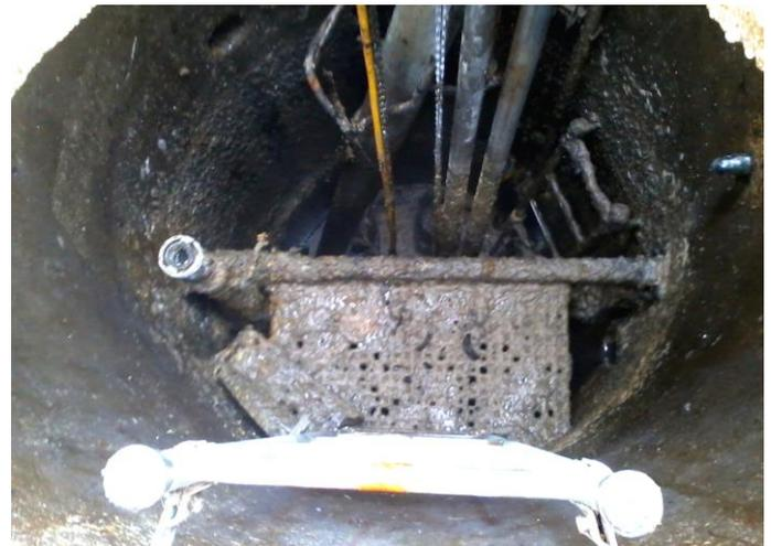
Störungsbehebung Abwasserpumpwerk, Schaden ausgelöst durch Putzlappen und Feinstrumpfhosen.
