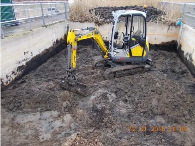
Ein Becken der Klärschlammvererdung wurde geräumt und das Drainagesystem neu aufgebaut.
