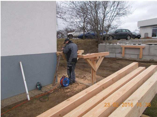
Bei unserem Arzt Dr. Tölle wurde ein barrierefreier Zugang geschaffen. Dieser wurde auf einer Lärchenholzkonstruktion aufgebaut und mit Gitterrosten ausgestattet, damit der Zugang immer frei von Schnee bleibt. Ein großes Dankeschön gebührt Familie und Firma Prinz, dass dieser Zugang über das Betriebsgrundstück ermöglicht wurde. Fahrzeuge von Arztbesuchern sind jedoch am Gemeindeparkplatz gegenüber der Raika abzustellen.
